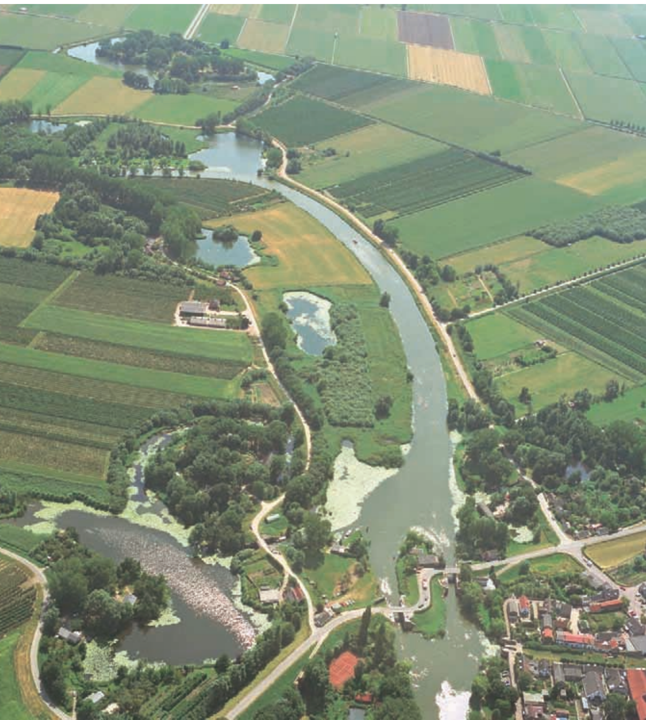
Boven ♦ Fort Asperen, de Wapenplaats aan de overkant van de Linge en (geheel boven) de vooruitgeschoven post Fort aan de Nieuwe Steeg; alle drie beveligden het Linge-acces. Rechts ♦ Fort tijdens restauratie zonder gronddekking, 2009.
