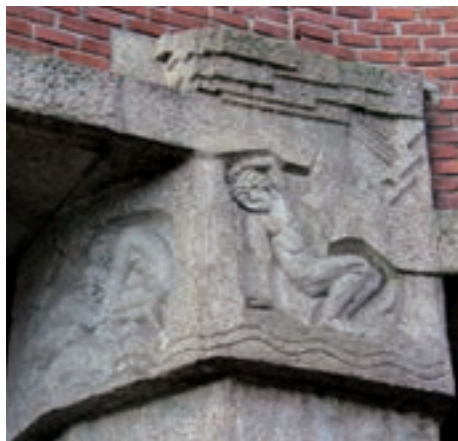
Gevelbeeldbeelden naar ontwerp van Louis van der Noordaa op het Centraal Gebouw.
